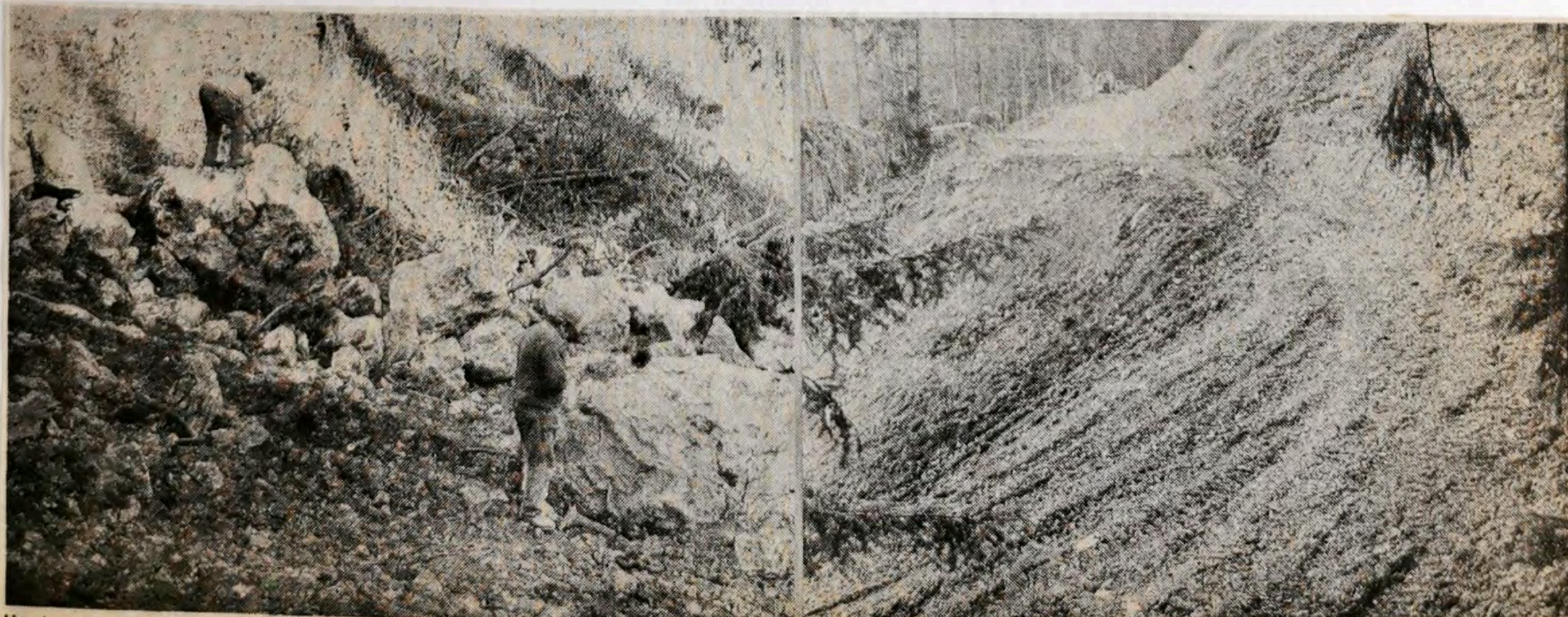
Um den „nördlichen Garlandgraben“ auch für mittelmäßige Skiläufer befahrbar und zu einem günstige Herbstwitterung hat die „Pisten-Ingenieure“ rascher als erhofft vorankommen Teilstück der vorderen Brauneckskiabfahrt zu machen, müssen gewaltige Felsblöcke gesprengt und als Auffüllmaterial verwendet werden (Foto oben links). Die insgesamt der Abfahrt.
