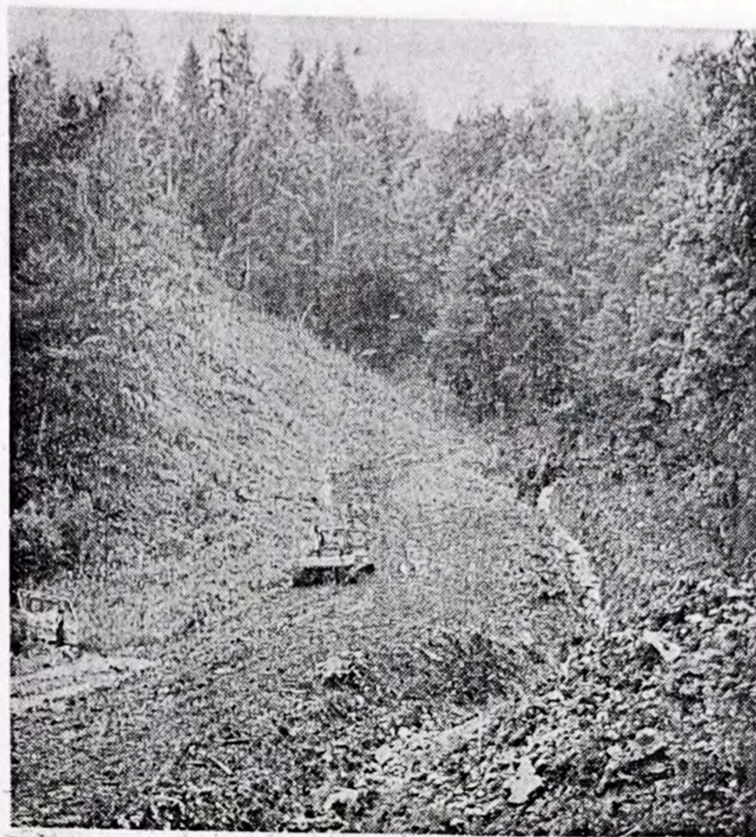
Zügig voran gehen die Arbeiten am Steilhang der Vorderen Brauneckabfahrt. Rechts im Bild ist der Drainage-Graben zu erkennen, links ein Lkw mit Füllmaterial, im Hang die Transportraupe, die das Füllmaterial in den Graben schiebt.
