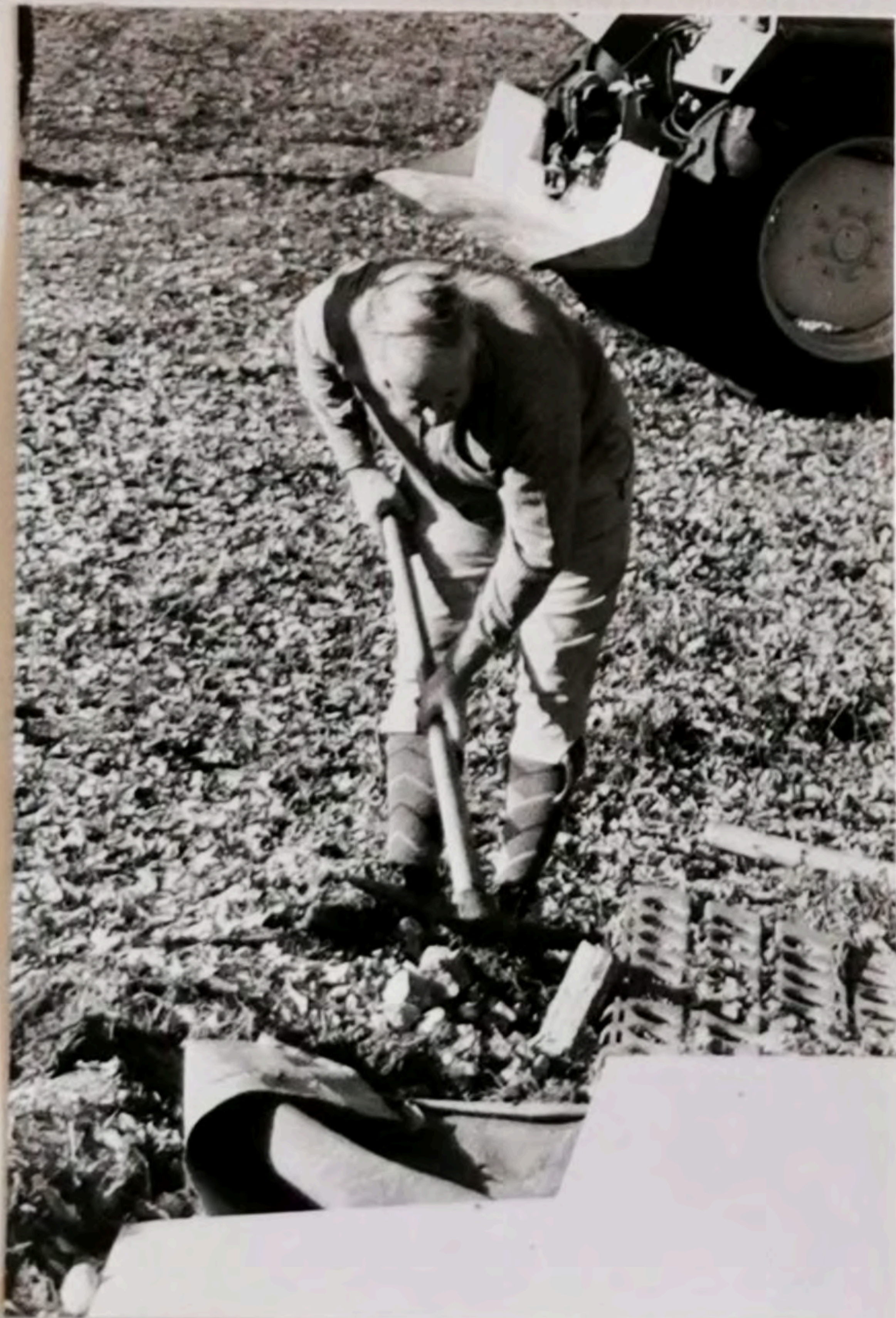
Der „Boss“ beim Kabel eingraben - für die Zeitmessung.
