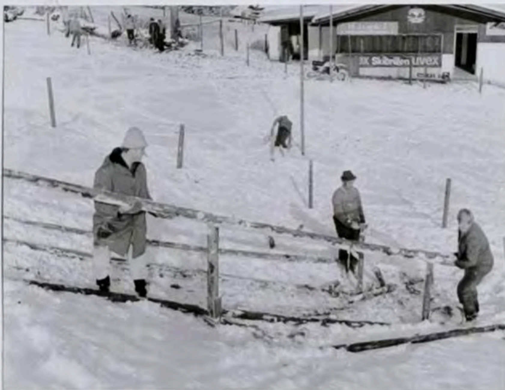
beim Errichten der Ehrentribüne (wie gehabt!)
